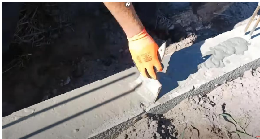
Zdj. 8 Pokrycie ławy fundamentowej płynną izolacją przeciwwilgociową.
