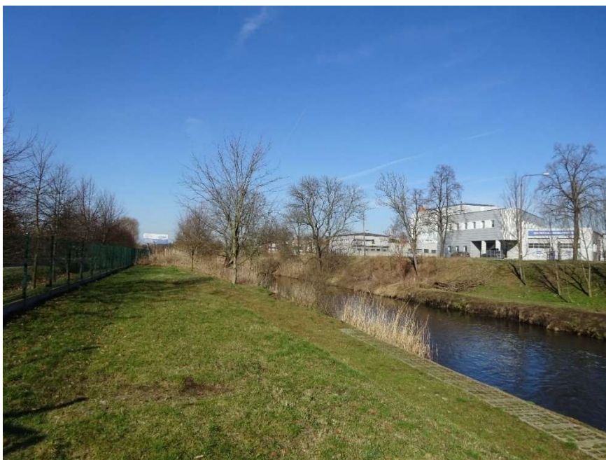
Fot. 2. Obszar objęty opracowaniem – Kłodnica w rejonie oczyszczalni ścieków. Źródło: Referat Pracowni Urbanistycznej
