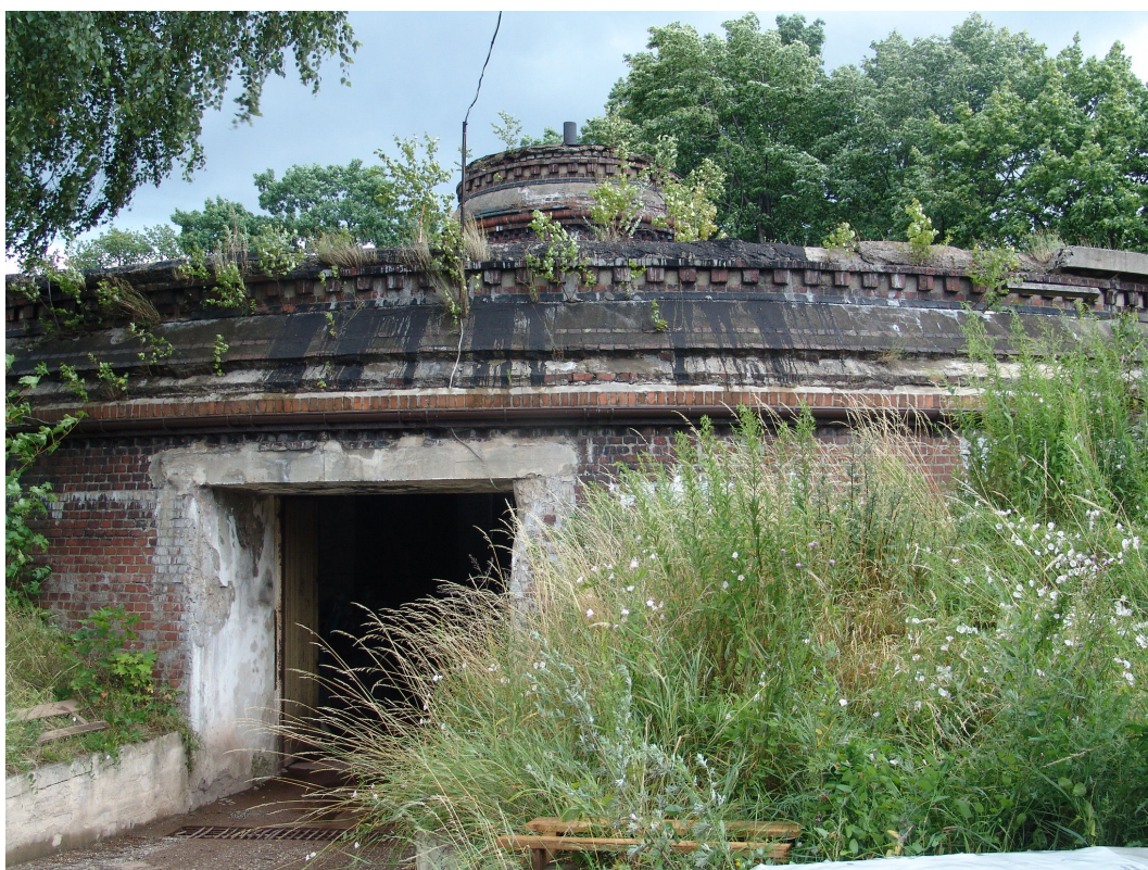
Fot. 15. Zbiornik na wodę, obiekt związany z wieżą ciśnień przy ul. Leśnej/Poniatowskiego Źródło: MKZ Ewa Pokorska
