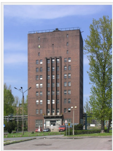
Fot. 1. Wieża ciśnień
