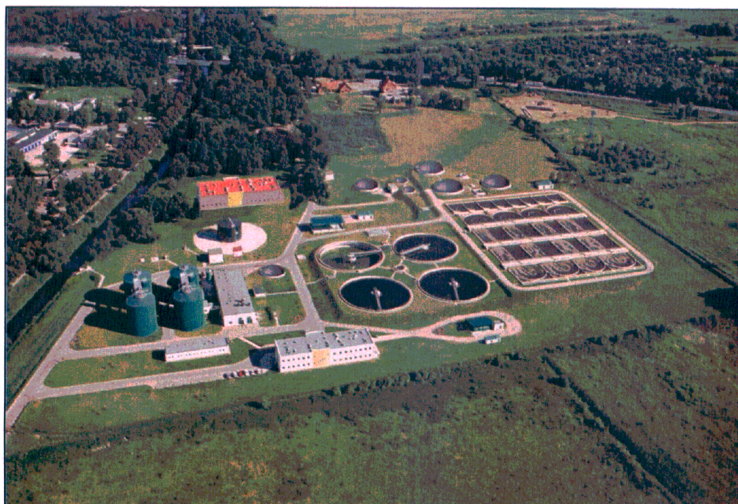
Rysunek 5 Centralna Oczyszczalnia Ścieków w Gliwicach
