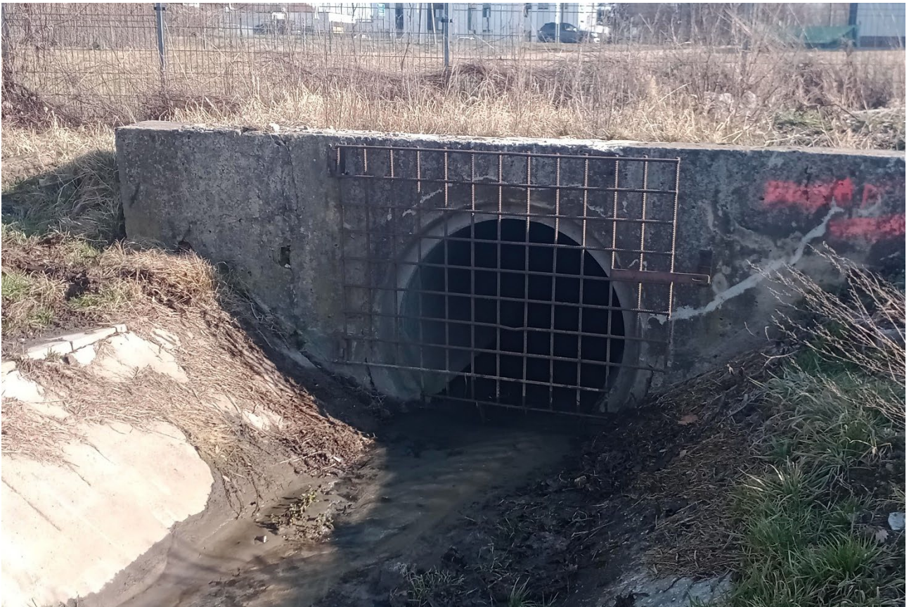
Źródło: Przedsiębiorstwo Wodociągów i Kanalizacji w Gliwicach
