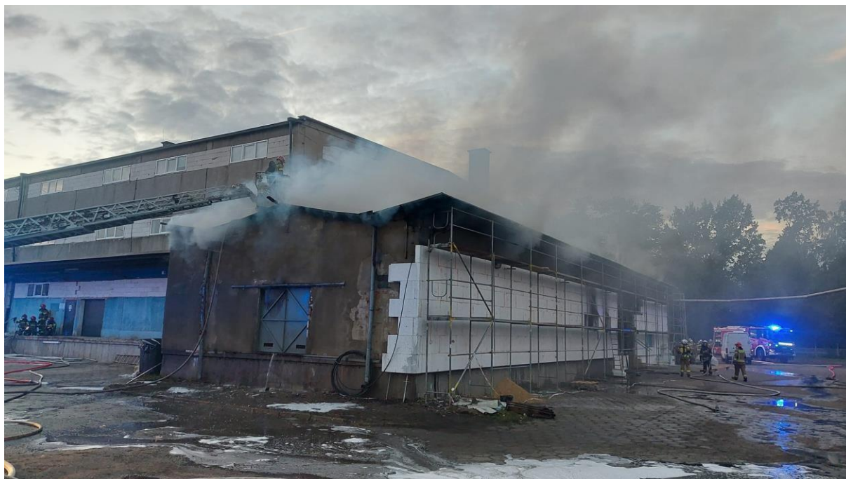
Fotografia 10 Pożar hali magazynowej, Gliwice ul. Portowa 10, 13.10.2023
