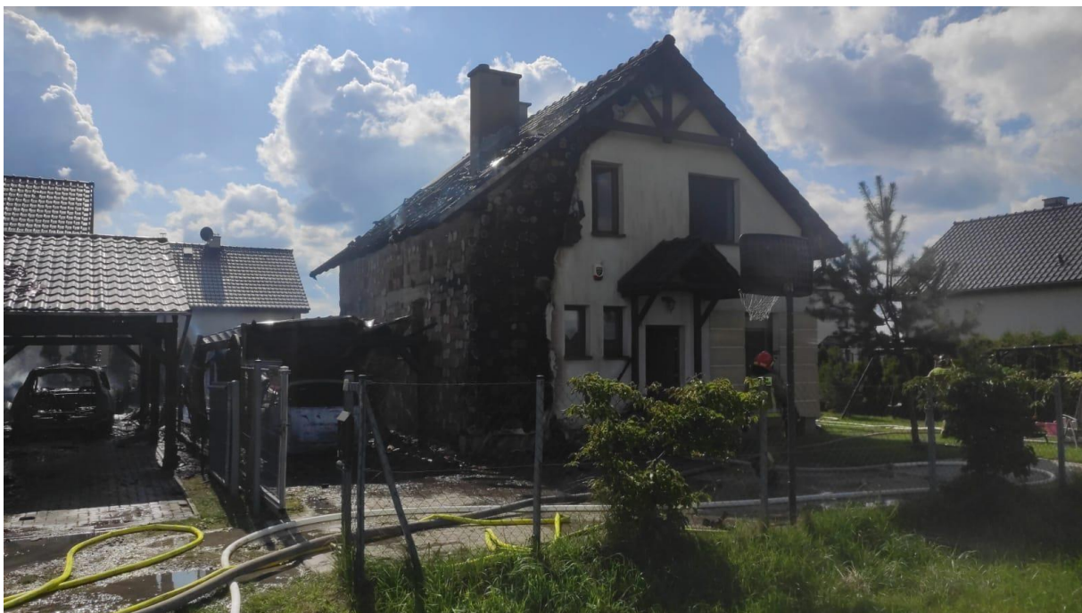
Fotografia 9 Pożar wiat w Sośnicowicach, 03.09.2023 r.
