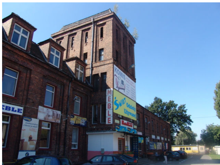
Fot. 10. Zabudowania KWK Sośnica przy ul. Sikorskiego 122 Źródło: MKZ Ewa Pokorska
