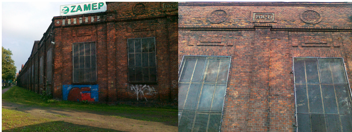
Fot. 7. Budynek przy ul. Świętojańskiej Źródło: MKZ Ewa Pokorska
