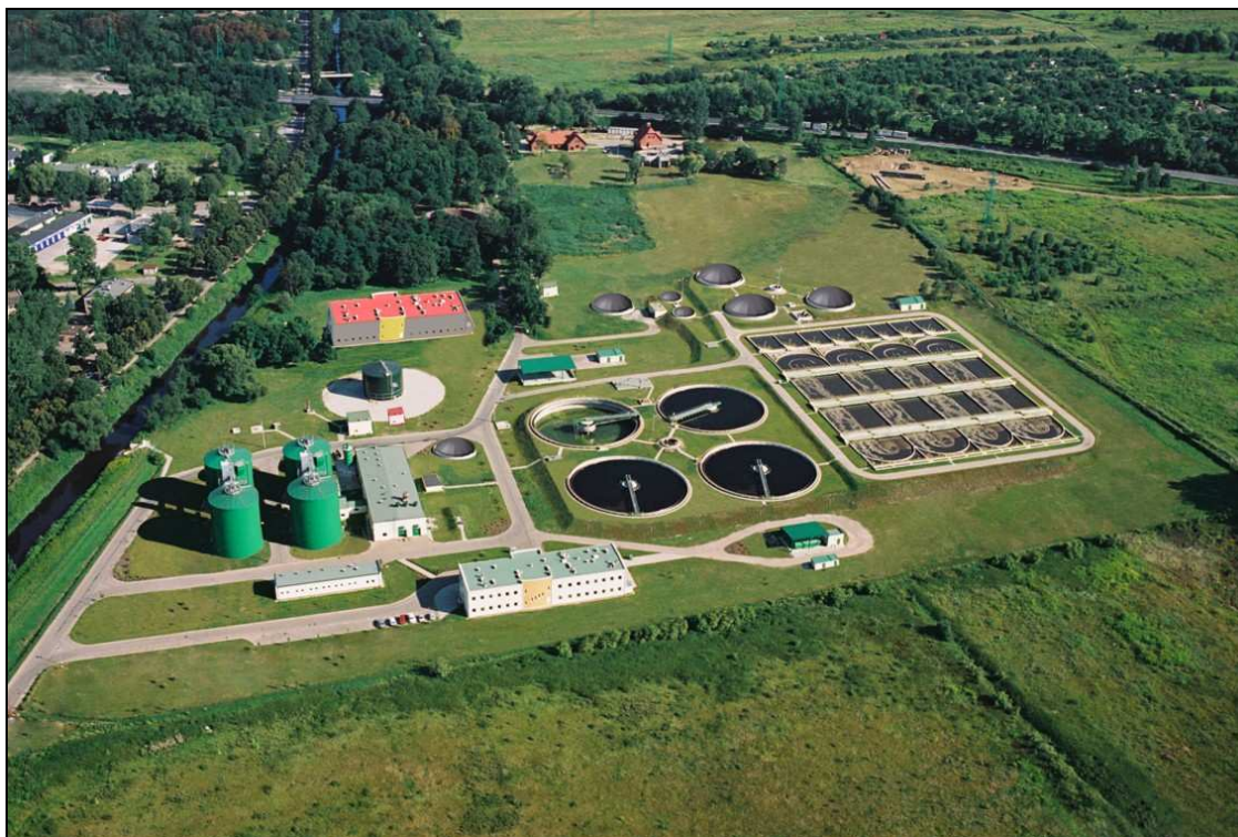
Rysunek 5 Centralna Oczyszczalnia Ścieków w Gliwicach
