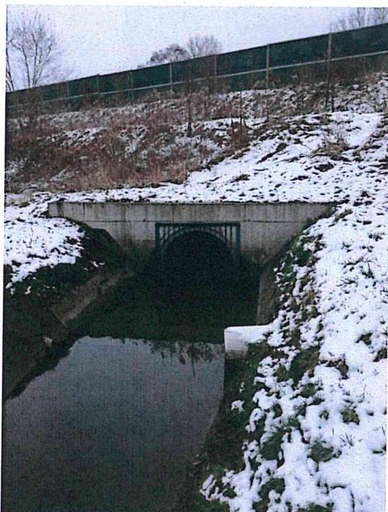
Krata na rowie RJ przy ul. Bydgoskiej.
