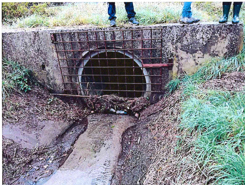
Krata na rowie RV przy ul. Tarnogórskiej.
