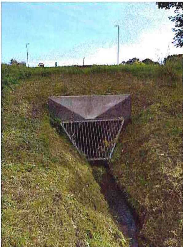
Krata na rowie RD przy ul. Daszyńskiego
