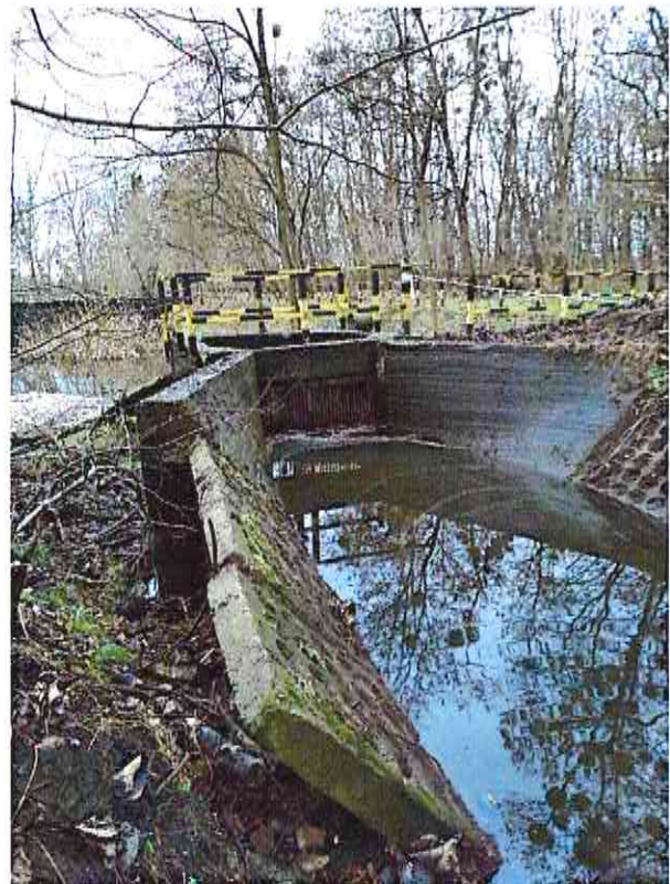
Krata na Potoku Leśnym przy ul. Zygmuntowskiej
