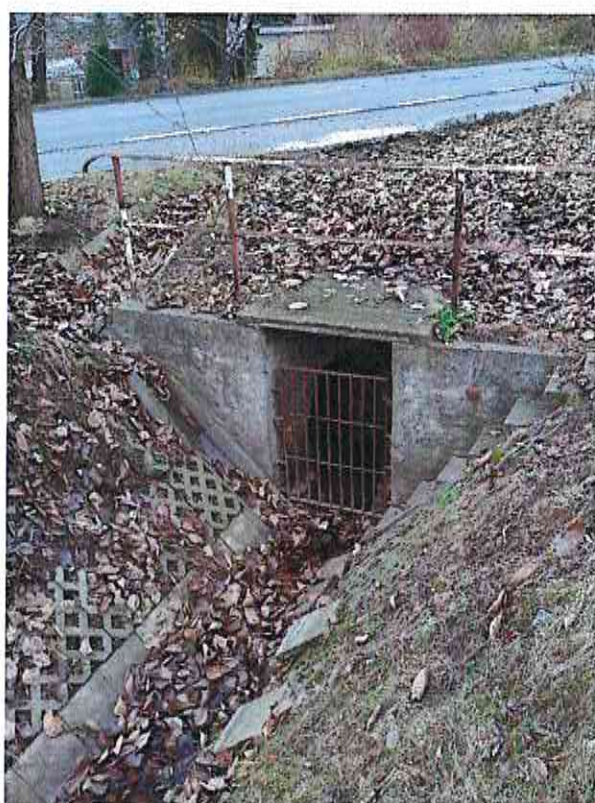
Krata na rowie RA2 przy ul. Rybnickiej
