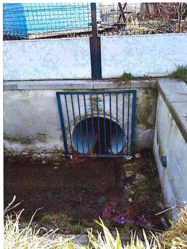
Krata na rowie R19 przy ul. Żernickiej
