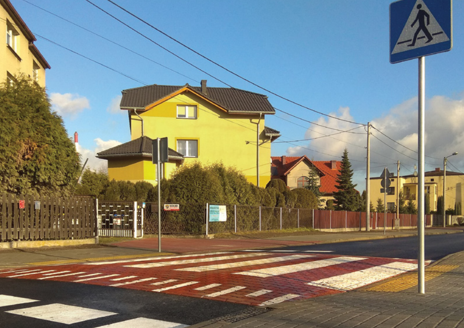
Przeście wyniesione, wyróżnione kolorem. Bieruń, ul. Marcina (fot. Aneta Gąska, UM Bieruń)
