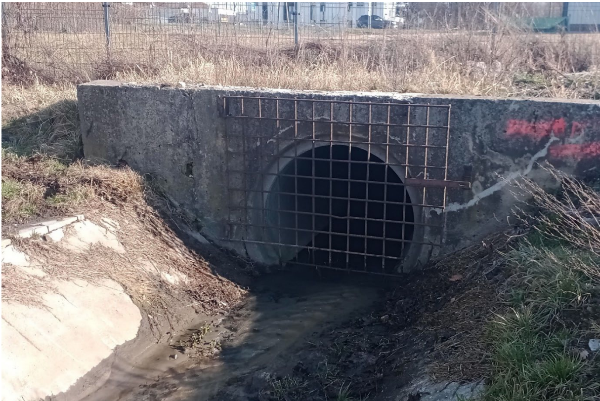
Źródło: Przedsiębiorstwo Wodociągów i Kanalizacji w Gliwicach
