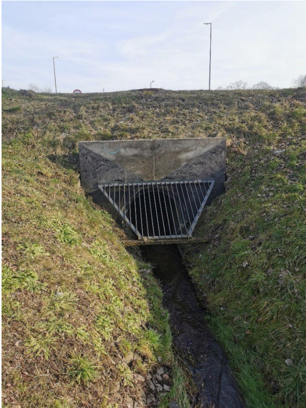
Krata na rowie RD przy ul. Daszyńskiego
