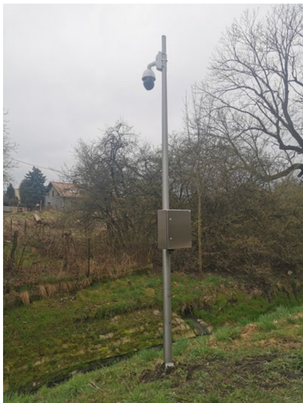
Kamera przy Ostropce (ul. Słowackiego)
